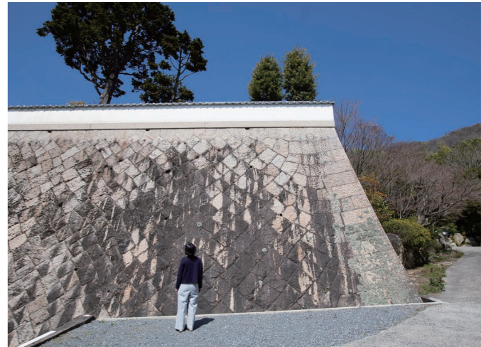
高さ10mを超える石垣。連島石が用いられていると考えられていたが、最近、北木島産であることが判明した。
