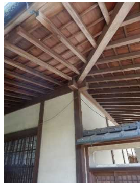
軒天井 化粧垂木に小舞天井 杵無垢天井板
