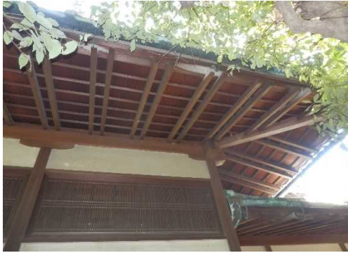
玄関廻り軒天井 吹寄せ垂木 杵無垢天井板
