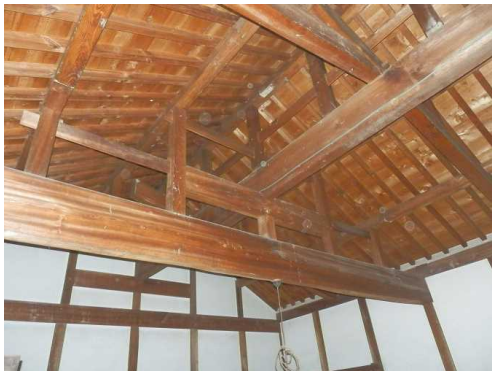
内蔵の小屋組みは束建と登梁を交互に使い双方の良さで、補い合っている
