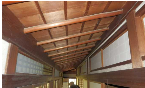
廊下の天井は杉丸太の垂木に小舞天井となっている
